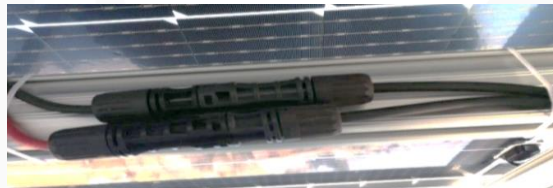
Ilustración 13 - Conectores MC4 correctamente instalados y fijados.
