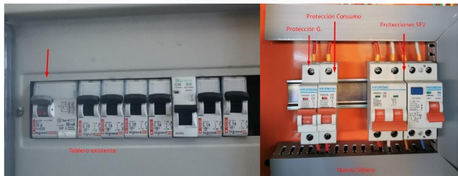
Ilustración 19 - Protecciones tablero existente (izquierda) y protecciones nuevo tablero general sin diferencial.
