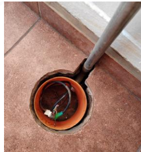
Ilustración 31 – Corte de buena terminación realizado a piso de cerámica para instalar camarilla de registro.
