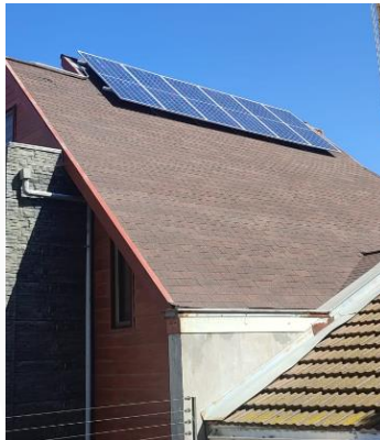
Ilustración 9 – Paneles instalados correctamente en la parte más alta de la cubierta disponible.
