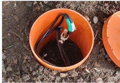
Ilustración 28 - Conductor de Tierra de servicio y Tierra de protección hasta el electrodo marcados y con holgura.
