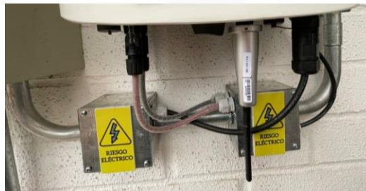
Ilustración 34 – Señalética cajas de derivación
