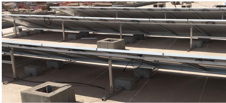
Ilustración 5 - Lastre utilizado para instalaciones fotovoltaicas en losa de hormigón.
