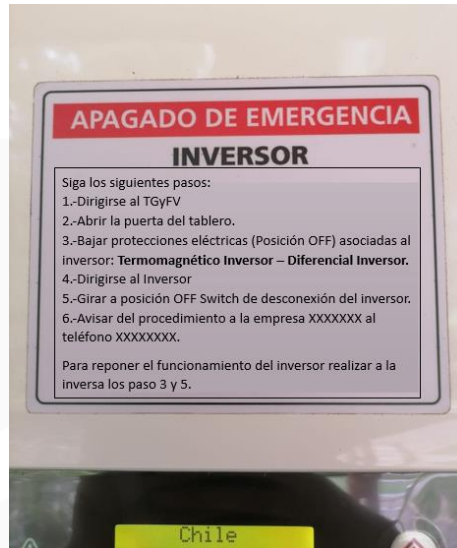
Ilustración 35 – Procedimiento de apagado adherido al inversor.
