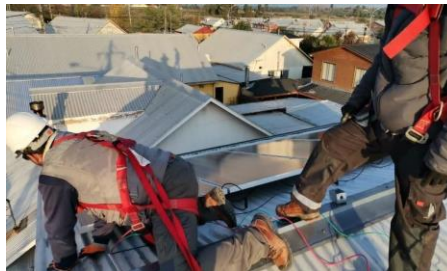
Ilustración 3 - Equipo de seguridad para trabajos en altura.
