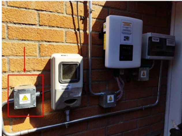
Ilustración 17 - Ejemplo de caja de derivación donde se encuentra la extensión.
