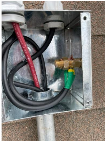
Ilustración 25 – Caja de derivación aterrizada con perno de puesta a tierra.
