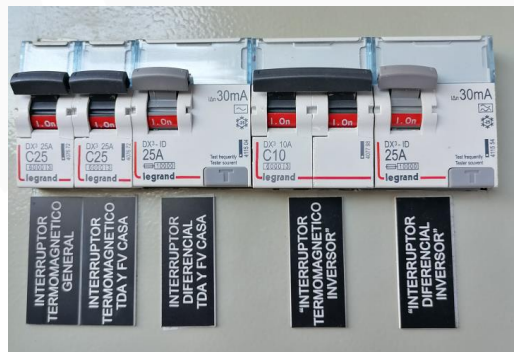
Ilustración 22 - Rotulado de protecciones en panel cubre equipos.
