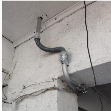
Ilustración 11 – Uso de flexible para curva complicada protegido de radiación UV.
