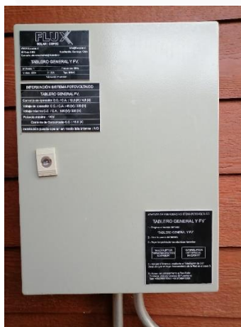
Ilustración 24 – Señaléticas pegadas en la tapa del tablero.
