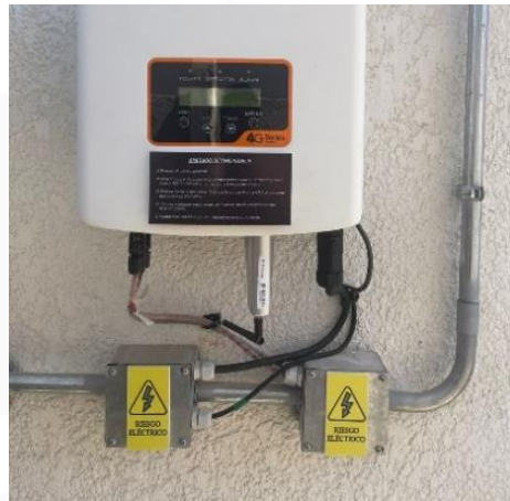
Ilustración 15 - Tramo entrada CC
