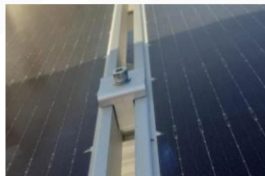
Ilustración 8 - Grapa de fijación de paneles fotovoltaicos.
