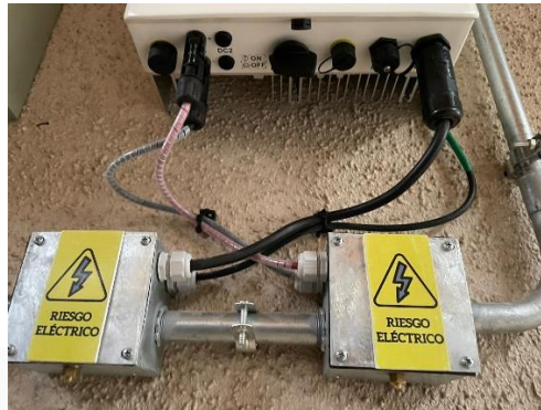
Ilustración 19 - Tramo entrada CC y salida CA del inversor.
