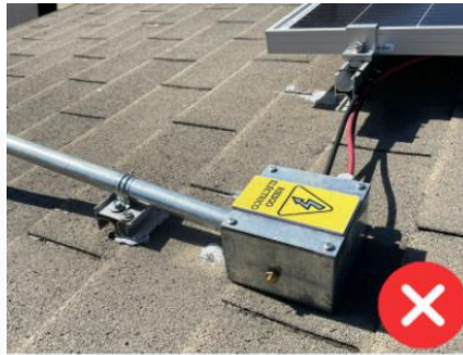
Ilustración 12 – Conductores expuestos al sol debido a una ruta incorrecta de la canalización.
