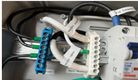
Ilustración 21 - Rotulado de conductores.
