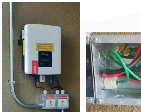
Ilustración 27B – Cajas AC y CC juntas con una prensa estopa que protege el conductor de puesta a tierra
