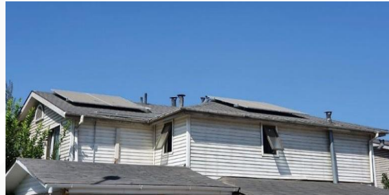
Ilustración 2 - Distribución en dos aguas con misma orientación para un proyecto de 2 kWp
