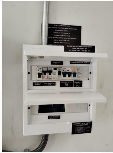
Ilustración 18C – Tablero plástico para interior.
