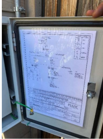
Ilustración 23 – Diagrama unilineal plastificado y pegado en el interior de puerta exterior del TGyFV.
