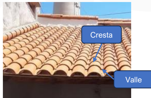
Ilustración 6 – Cresta y valle de techo de teja
