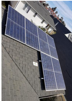
Ilustración 1 - Distribución en L para un proyecto de 2 kWp
