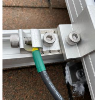
Ilustración 26 - Conductor de Tierra Protección con terminal aterrizando estructura de paneles.
