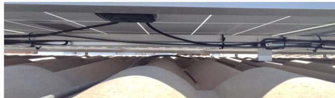
Ilustración 14 - Correcta sujeción del cableado.
